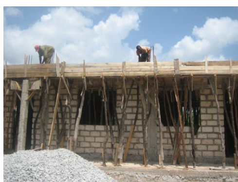
Vorbereitungen für die Deckenkonstruktion
