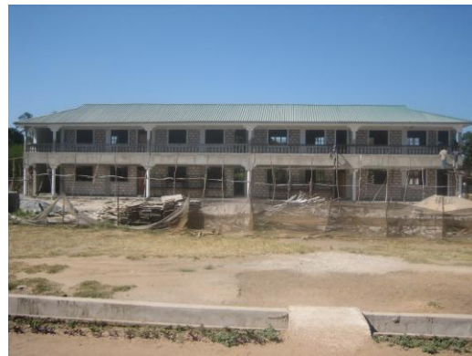
Schulgebäude mit Kanalgraben
