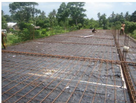
Vorbereitungen für die Deckenkonstruktion
