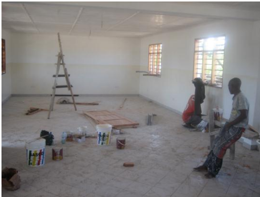
Der Innenausbau kann beginnen .
